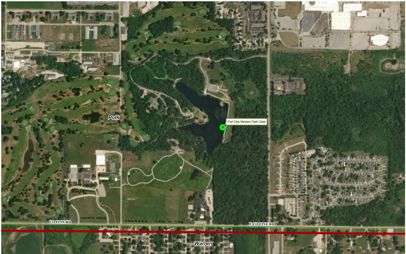
Figure 3.42. Fort Des Moines Park Dam
